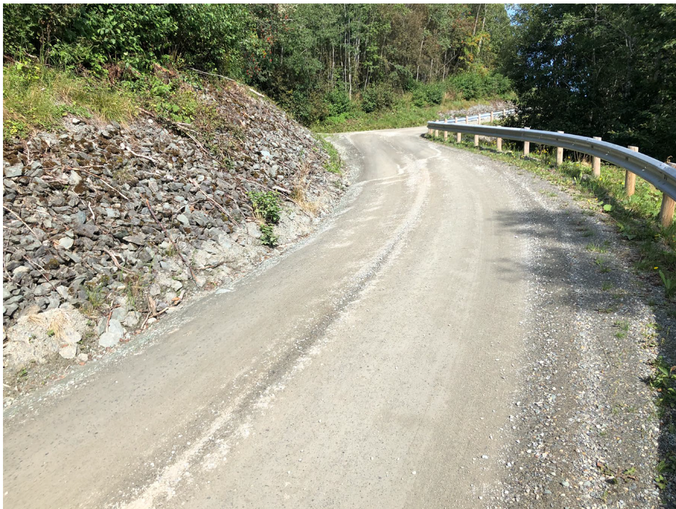
Figur 1: Bildet viser dagens vegstandard gjennom Kregnesbakken med stor stigning og lite kantareal langs vegen.
